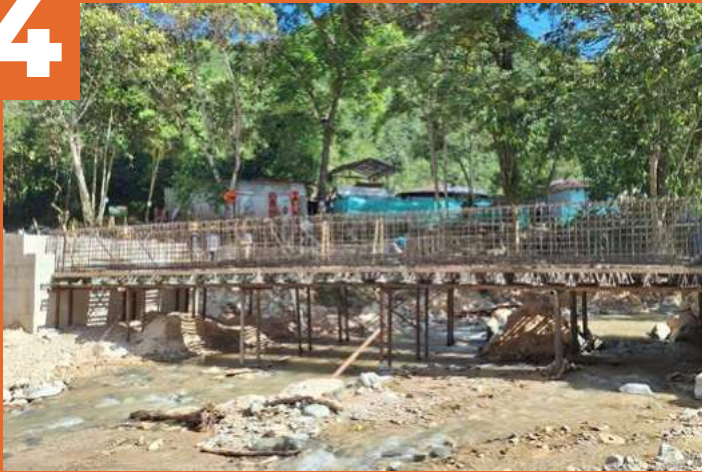
El Gobierno programa visitas a estas obras para verificar el cumplimiento y avance. Foto ART
