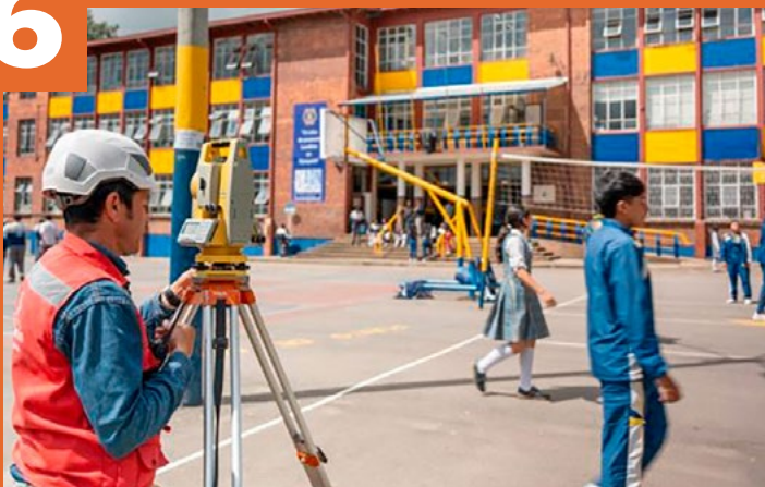
Comenzaron las obras en la Institución Educativa Municipal San Juan Bautista de La Salle, de Zipaquirá. Foto Mineducación
