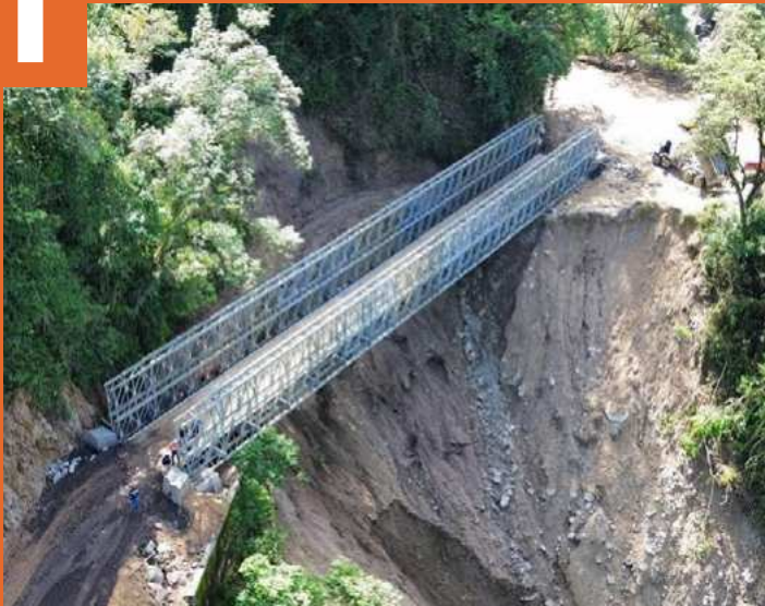
El puente Curos-Málaga es un hecho por la ejecución del Gobierno que garantiza la movilidad para 130 mil habitantes de la región. Foto MinTransporte
