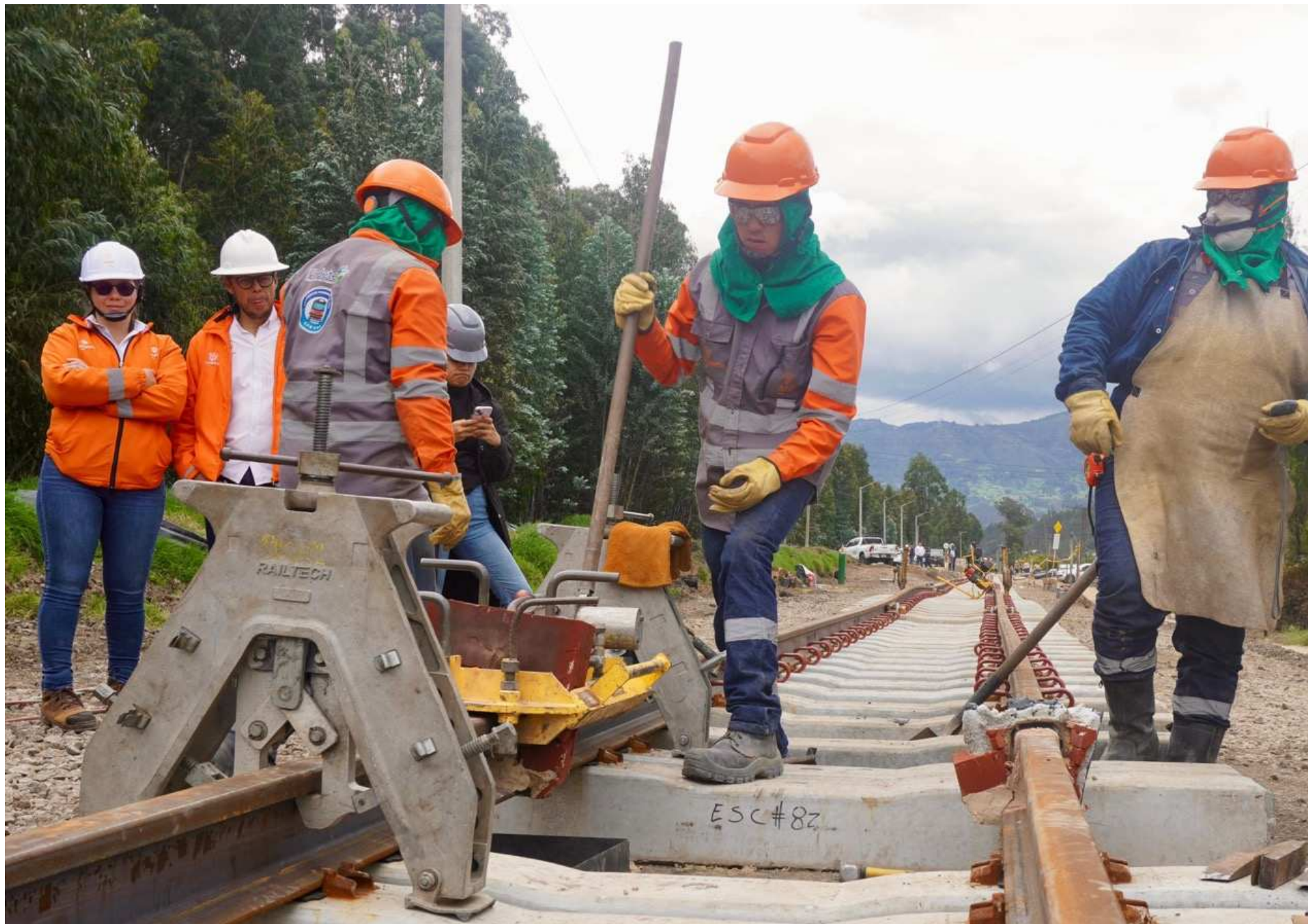
Sigue la recuperación del Corredor Ferroviario Bogotá – Belencito. Foto Ministerio de Transporte
