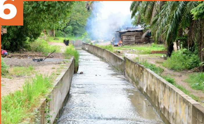
La obra es una solución definitiva al riesgo de inundaciones y socavación que durante dos décadas afectó a la población de Barrancabermeja. Foto Ungrd
