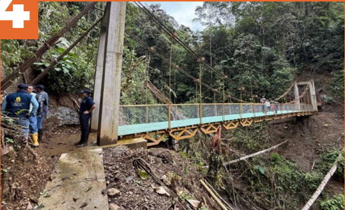
Las estructuras metálicas con acceso en concreto garantizan condiciones de movilidad segura y digna en las zonas rurales del municipio. Foto Ungrd
