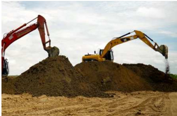
La intervención para remover medio millón de metros cúbicos de tierra se hace en la margen derecha del río Cauca, en San Jacinto (Bolívar). Foto Ungrd
