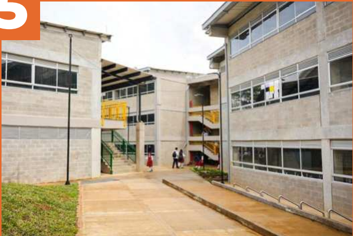
Son dos obras completadas en el municipio para 2.346 estudiantes. Foto FFIE
